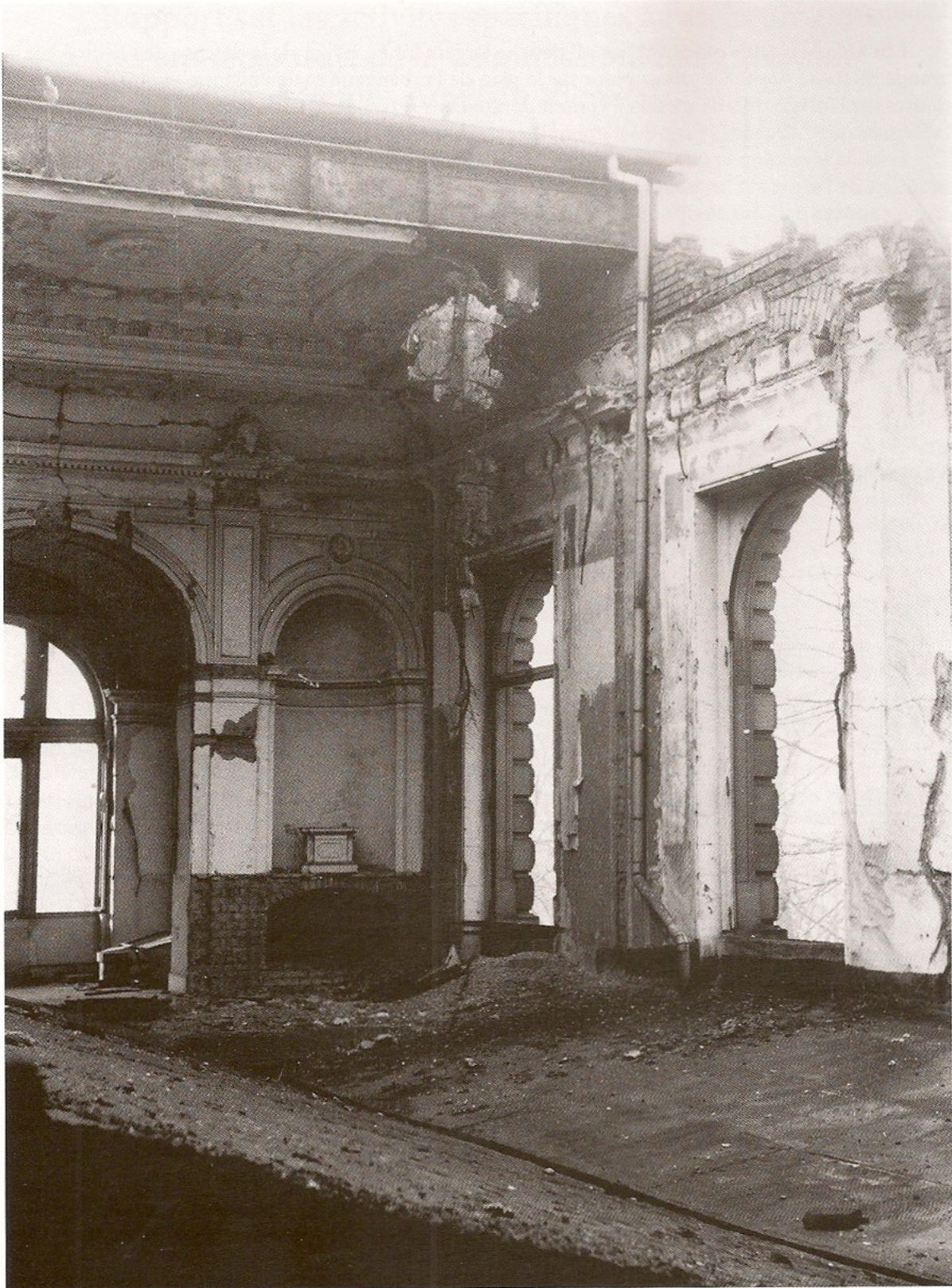
La salle des banquets, avec les murs nord et ouest détruits lors du bombardement du 25 septembre 1944 ( DRAC Alsace, Conservation Régionale des Monuments Historiques, cliché n° 8525).
